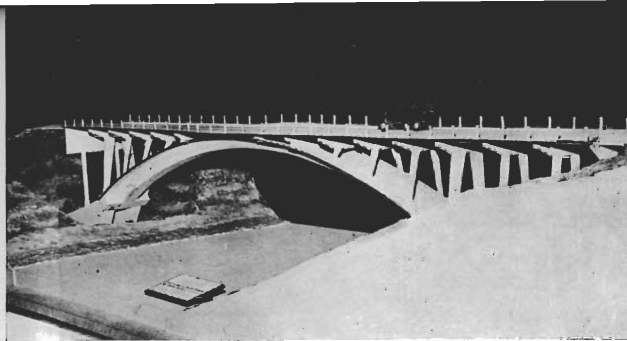
Figura I — Vista del puente a construirse, en la que se aprecia la lámina plegada del arco y la disposición de los pórticos.
