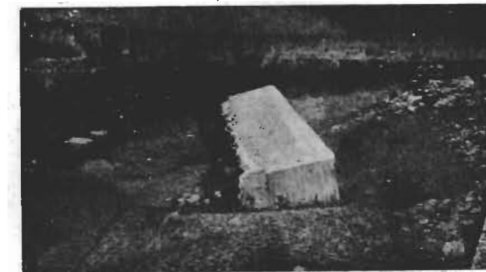
Figura 5. — Bloque de defensa de 60 toneladas arrastrado por las aguas.
