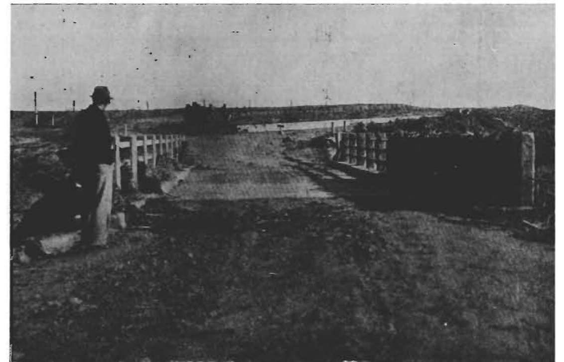
Figura 10. — Puente sobre el arroyo Rivero. Puede observarse la resaca acumulada en las barandas.
