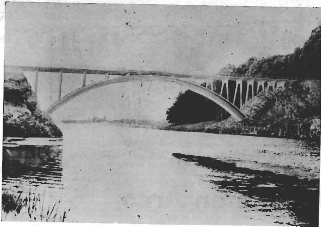
Figura 2 - Vista del puente en su lugar de emplazamiento.
