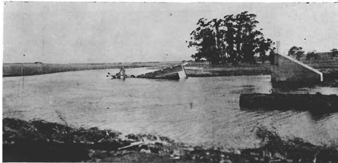
Figura 7. — Puente sobre el río Sauce Grande, en la Ruta Nº 3, de 60 metros de luz, destruido por las aguas en 1944.
