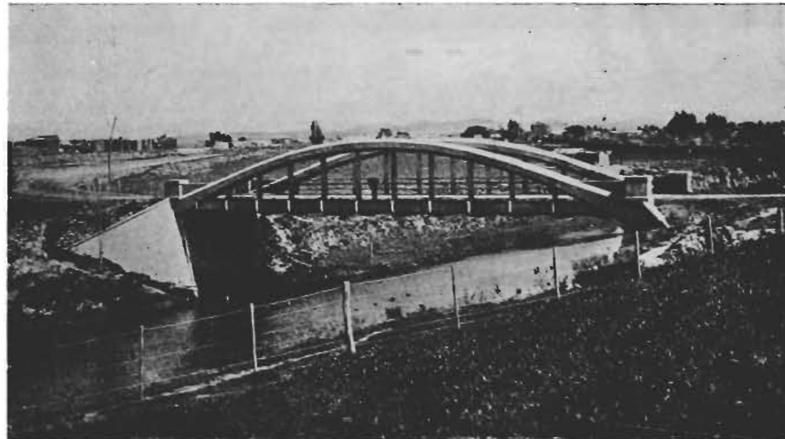
Figura 8. — Puente en arco en el camino Saldungaray-El Divisorio, sobre el río Sauce Grande, antes de la crecida de 1944.
