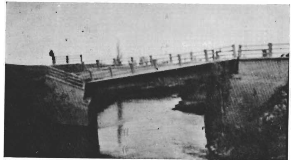
Figura 12 y 13. - Puentes sobre el río Sauce Grande en el bajo San José. La velocidad destructiva de la corriente ha socavado uno de los estribos.
